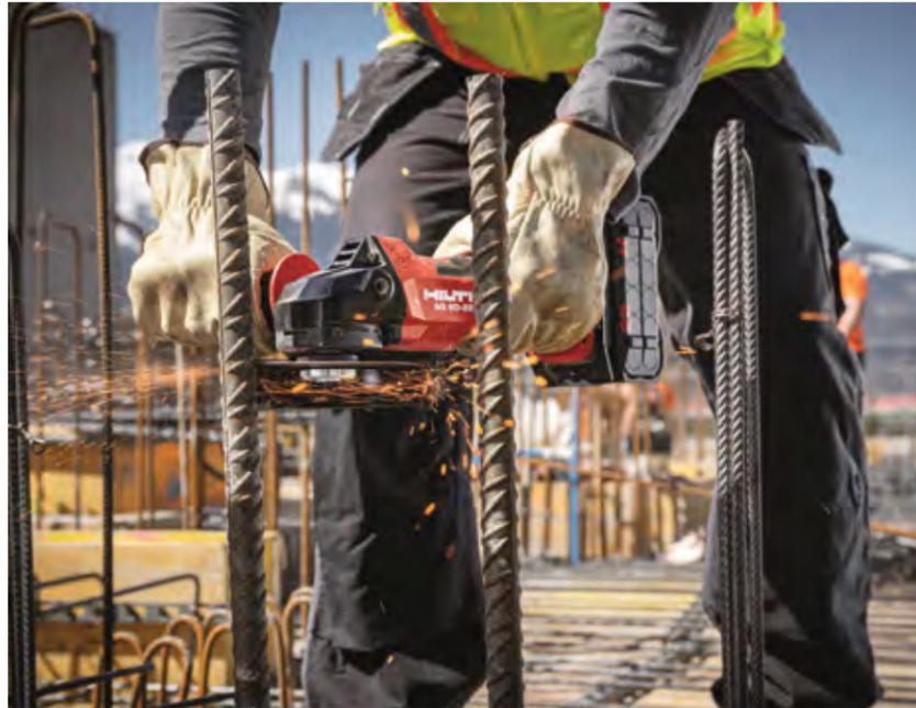
Der Akku-Winkelschleifer Hilti AG 6D-22 im flexiblen Einsatz: hier beim Schneiden von Bewehrungsseisen.
