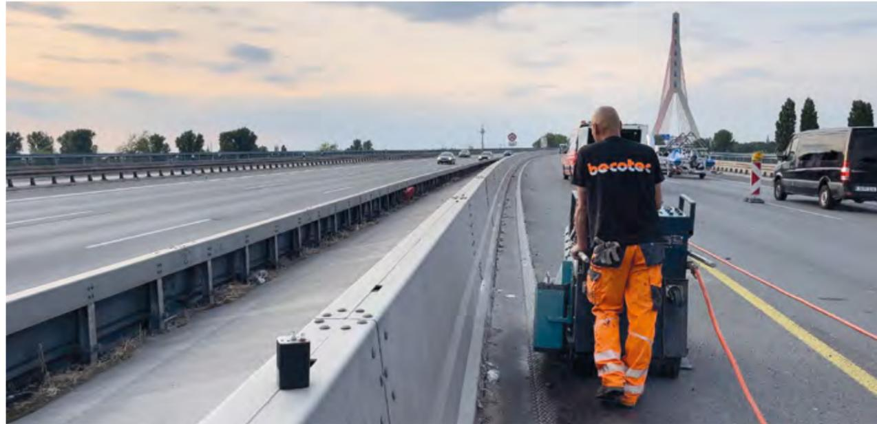
Die Firma Becotec aus Mönchgladbach übernimmt 1.000 Meter Trennschnitte im Asphalt bei der Deckenerneuerung der BAB 46.
