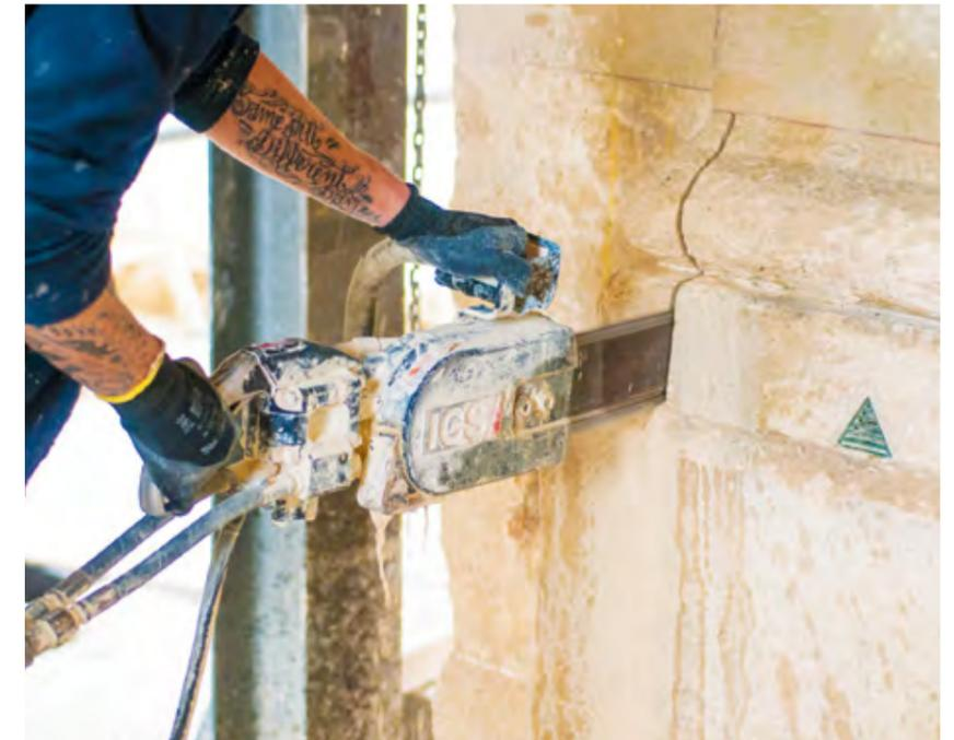
Mit der Diamantketten-Technologie von ICS gehen Kettensägen durch härteste Materialien.
