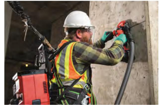
wird. Diese aktive Drehmomentkontrolle greift ebenso bei Rückschlag und ruckartigen Bewegungen während der Anwendung durch sofortiges Stoppen des Gerätes ein. Das Anhalten der Scheibe erfolgt durch eine zusätzliche Bremse in Sekundenschnelle. Diese kombinierten Sicherheitsfunktionen vermeiden Arbeitsunfälle, die durch Abrutschen des Gerätes passieren können.
