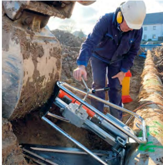
Das DD300 im Einsatz mit Bagger-Anpressblock.
