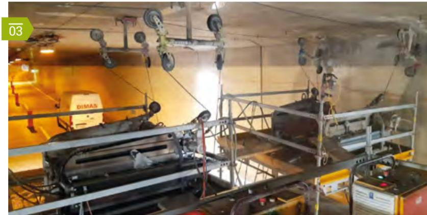
Die geschnittenen Betonteile wurden vom Auftraggeber auf die neue Tunneldecke nach oben gehängt. Der Ausbau und Abtransport erfolgte durch ein speziell entwickeltes Absenkgerät. Insgesamt werden 240 Betonteile mit einem durchschnittlichen Gewicht von 22,5 Tonnen geschnitten und ausgebaut.
