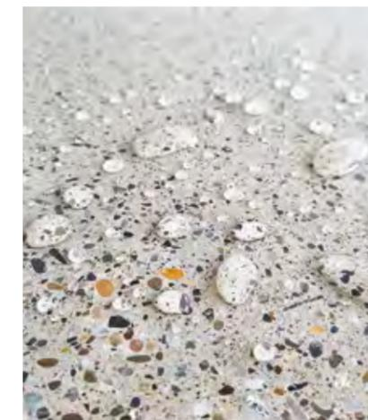
Nach Schliff und Polierung wurde der Boden wasser- und schmutzabweisend imprägniert.
